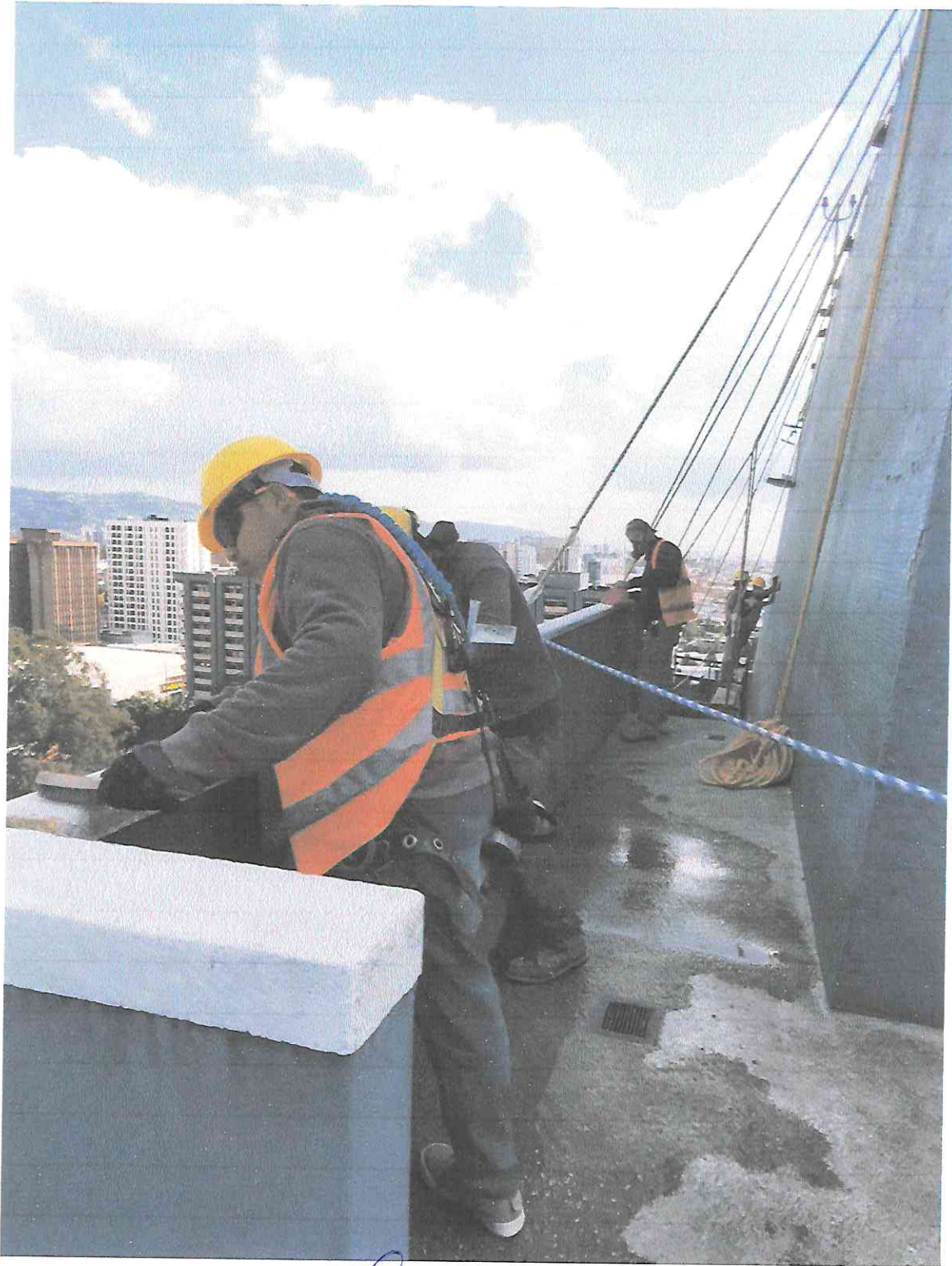
Limpeza y desinfección de tesela y bordillo del segmento B1 de la fachada Oriente.
